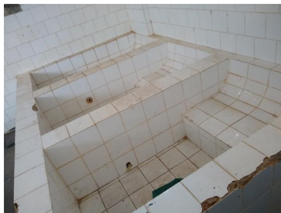
Figura 6: Estádio Juscelino Kubitschek, Manhuaçu/MG.
