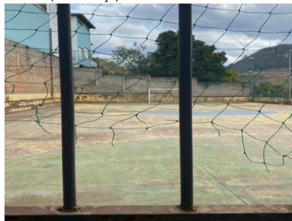
Figura 11: Quadra da Associação do Bairro Santana, Manhuaçu/MG.
