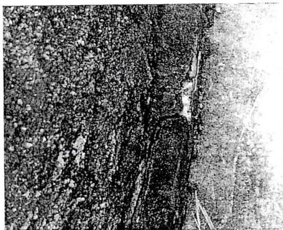
Figuras de N°s. 02 e 03 Trincas no pavimento acarretam na infiltração de água.
