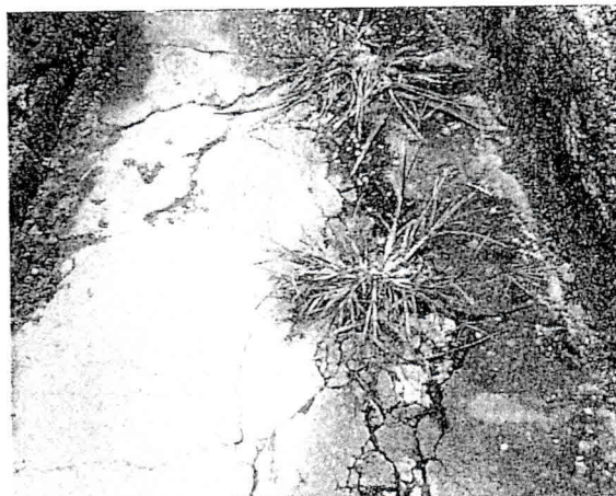
Figuras de N°s. 02 e 03 Trincas no pavimento acarretam na infiltração de água.
