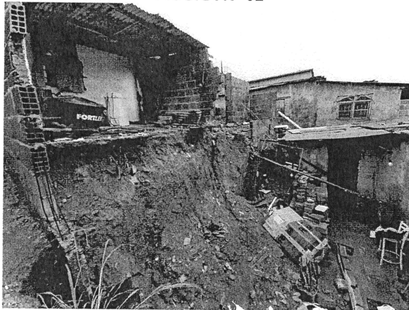
Ao fundo muro de contenção escorado.
