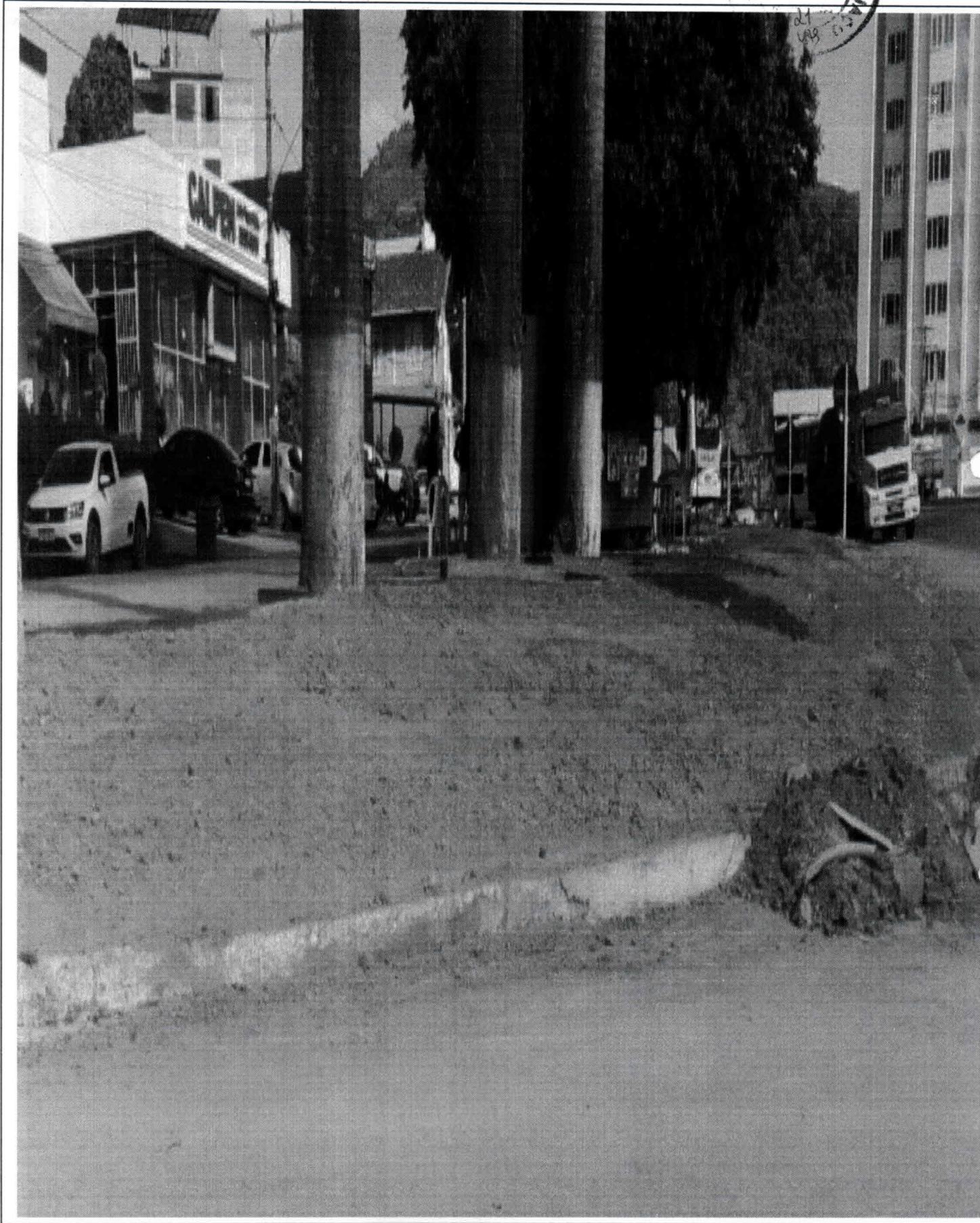
Lateral esquerda sentido a BH aonde se encontra ainda um trailer invasor(já denunciado varias vezes) de área da rodovia em frente a CALPEM AUTO PEÇAS BR262 sem autorização do DNIT,foi usado material humano Municipal,materiais de construção comprados com dinheiro Publico e maquinas a serviço do Município. Coordenadas Google maps: -20.256379, -42.027293
