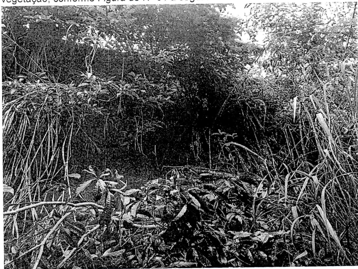
Figura Nº 01 – Superfície do talude tendo na sua crista o Beco do Wantuil.
